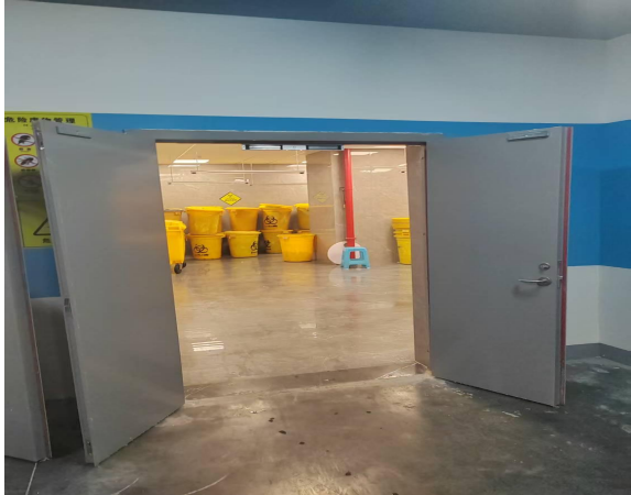
图3-30 综合楼-2F医疗废物贮存库
